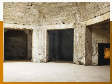
Il salone ottagonale, con un meccanismo idraulico che faceva ruotare il pavimento.
